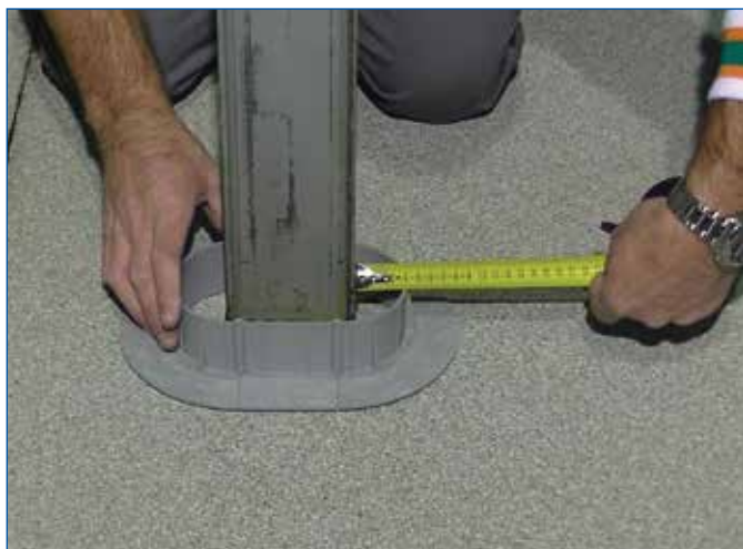
FIGURA 3 - Posizionamento del cassero
