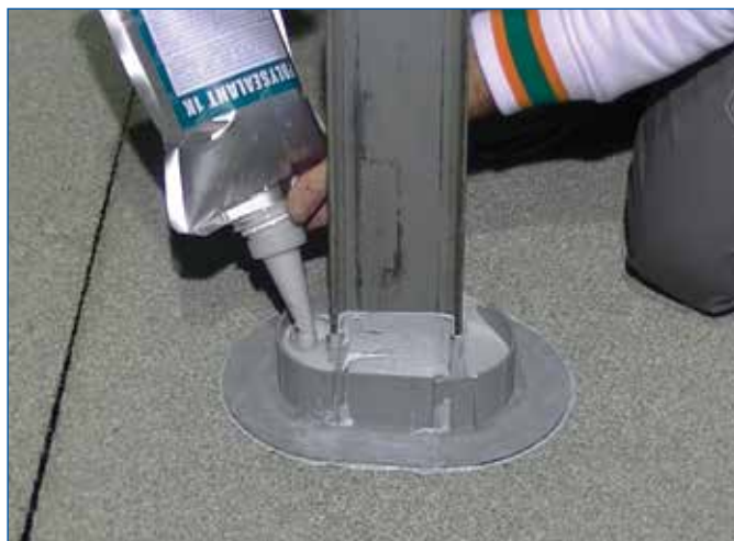
FIGURA 6 - Riempimento del cassero POLYSEALANT MOULD con POLYSEALANT 1K
