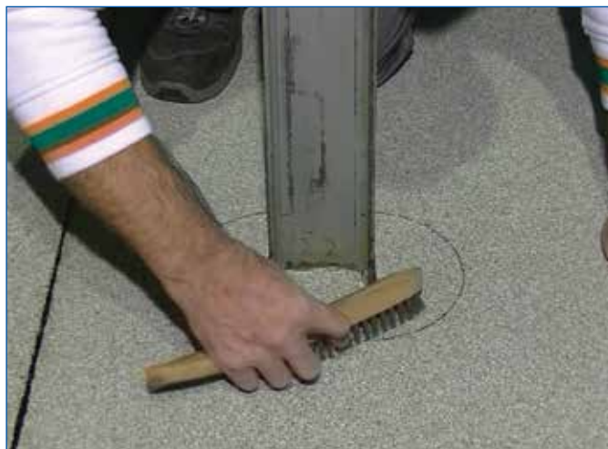
FIGURA 2 - Preparazione delle superfici
