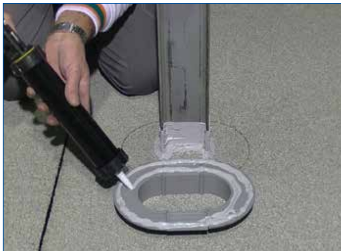
FIGURA 4 - Applicazione del sigillante adesivo POLYSEALANT CARTRIDGE
