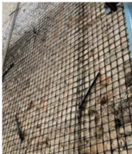
Rinforzi strutturali con sistema CRM
